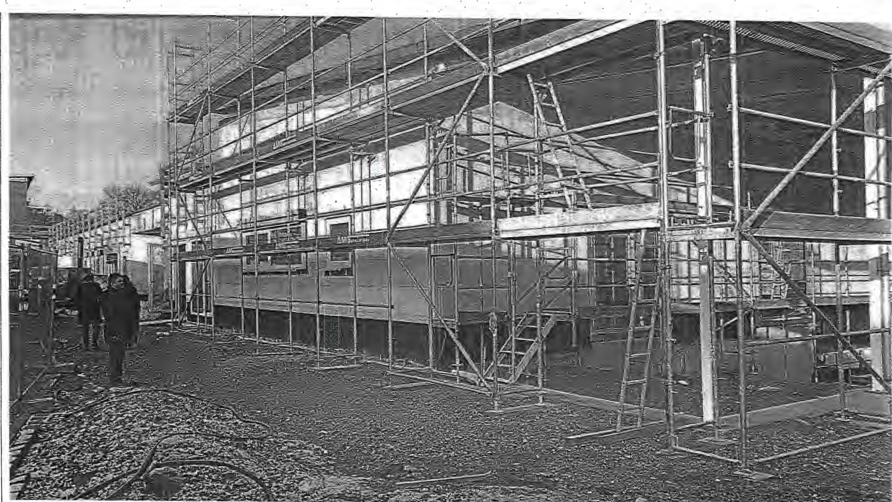
Die Baumaßnahmen auf dem Gelände in der Grunerstraße schreiten voran: Hier soll Ende des Jahres die Wäscherei der Vitos-Werkstatt entstehen.
