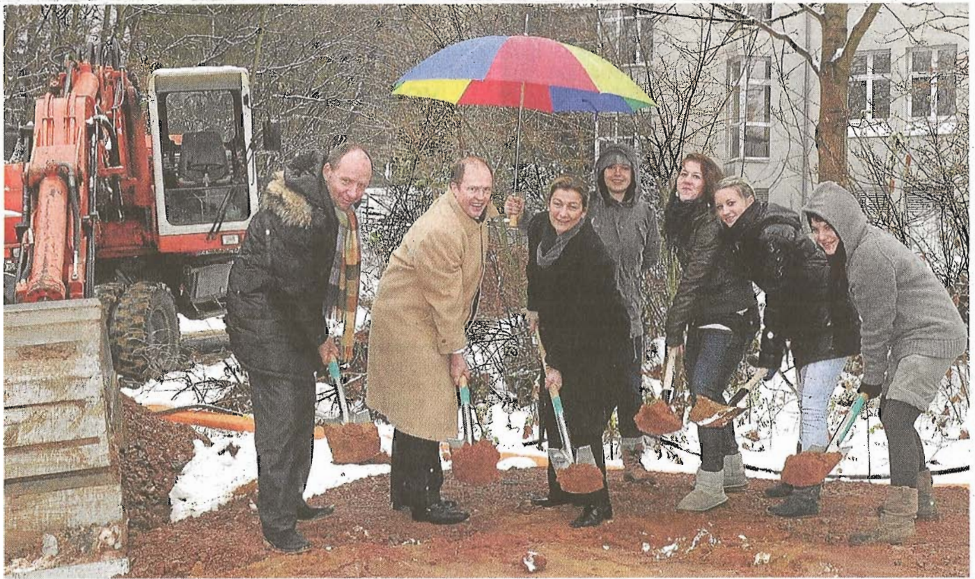
Buddeln im Sandschlamm (von links nach rechts): Architekt Gerhard Guckes, Landrat Burkhard Albers, PSI-Schulleiterin Ina Ofenloch und Schülerinnen des Pestalozzigymnasiums beim ersten Spatenstich für den Erweiterungsbau. Foto: wita/Mallmann
